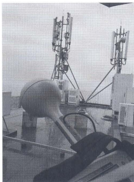
Figura 3: Pamje gjatë matjeve në antenat transmetuese të stacionit bazë.
