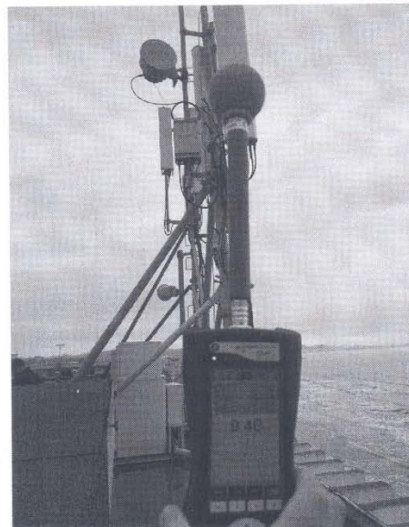
Figura 3: Pamje gjatë matjeve në antenat transmetuese të stacionit bazë.
